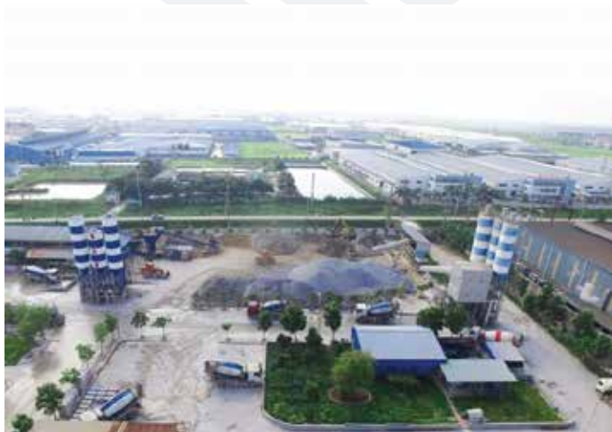
Nhà máy SKB tại KCN Quế Võ tỉnh Bắc Ninh những ngày đầu thành lập
